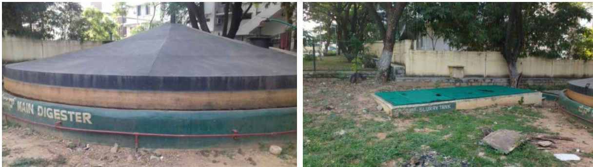
Abbildung 9: Kleinmaßstäbliche Biomethanisierungsanlage
