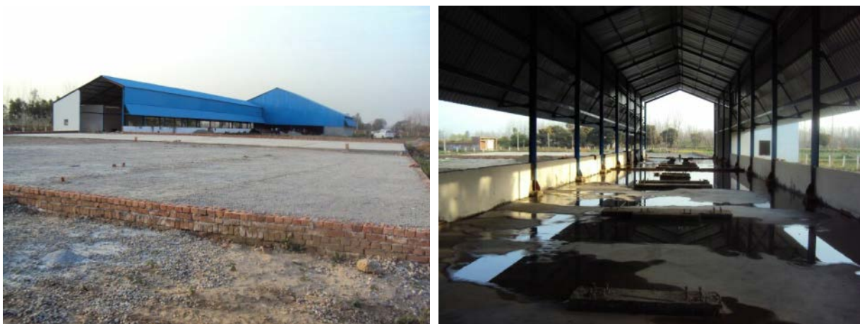
Abbildung 19: Bauzustand der Kompostieranlage, März 2017
