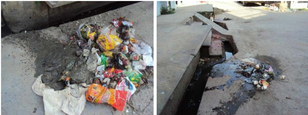
Abbildung 17: Aus offenen Kanälen entfernter Abfall und Schlamm
