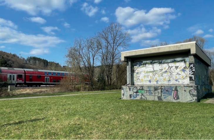
Nutzung vorhandener Infrastruktur – hier zur Trinkwassergewinnung – um neue Aufenthaltsmöglichkeiten entlang der neuen Regionalpark Kinzigauenroute schaffen.
