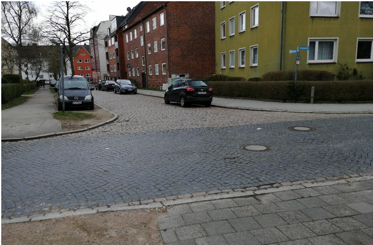
Abbildung 39: Zustand der Danziger Straße vor der Umgestaltung
