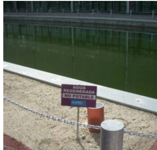
Abbildung 87: Entnahmestelle auf einem Park in Alicante mit violetter Rohrleitung und Warnhinweisen (Morote et al., 2019). Violette Warnschild auf einem dem „Campo Golf La Moraleja“ in Madrid (Madrid, 2023)
