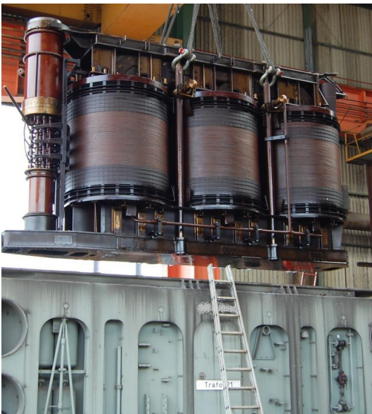
Abbildung 14: Dreiphasentransformator im Bau
