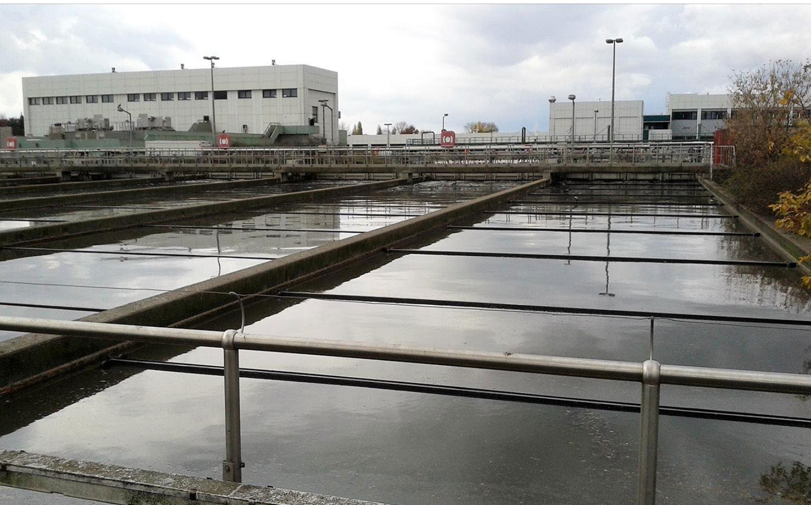
Vorklärbecken einer Kläranlage. Foto: Selinka.
