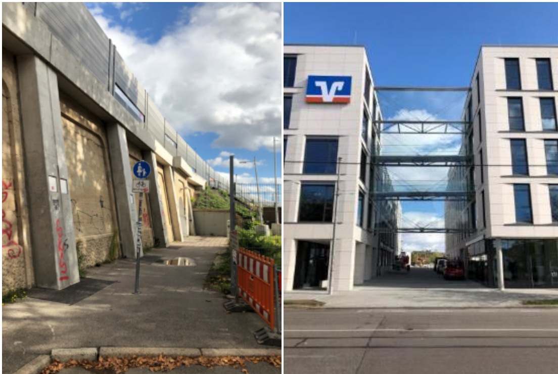
Abbildung 41: Lärmschutzwand entlang der Bahnlinie (links) sowie zwischen Baublöcken (rechts, im Bau)
