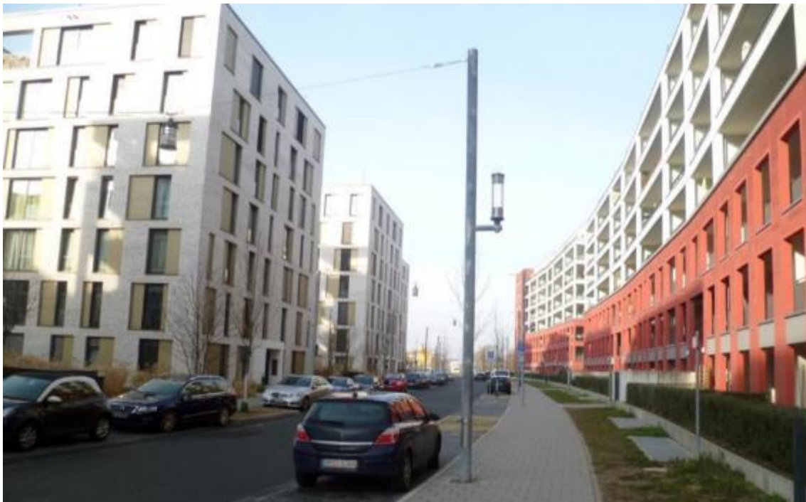
Abbildung 32: Lärmabschirmende Riegel-Bebauung (rechts) auf der Hafeninsel
