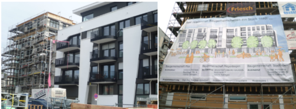
Abbildung 46: Quartier im Bau
