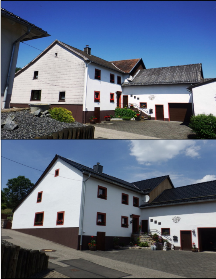
Bild 31: Ortstypische Fassaden- und Dacherneuerung in Dahlem (Oben: Vor der Maßnahme; Unten: Nach der Maßnahme), © Gemeinde Dahlem, Erwin Bungartz
