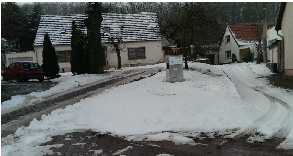
Bild 22: Standort einer Gruppenkleinkläranlage, © Wasserzweckverband WZV "Saale-Fuhne-Ziethen"
