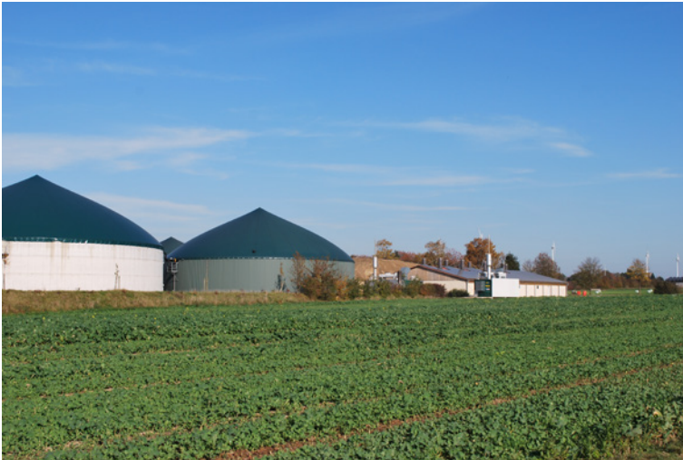
Bild 9: Biogasanlage, © Stadt Willebadessen, Fotografin Ingrid Menzel
