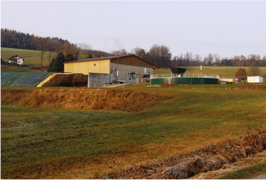
Bild 4: Biogasanlage, © Gemeinde Ascha, W. Zirngibl
