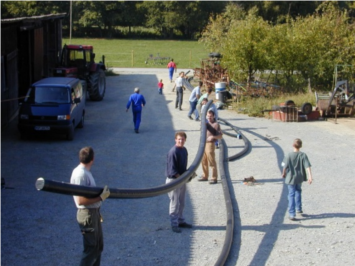
Bild 2: Bewohner von Binsfeld verlegen die Nahwärmeleitungen, © Franz-Josef Sauer/Das Dorf Service GmbH
