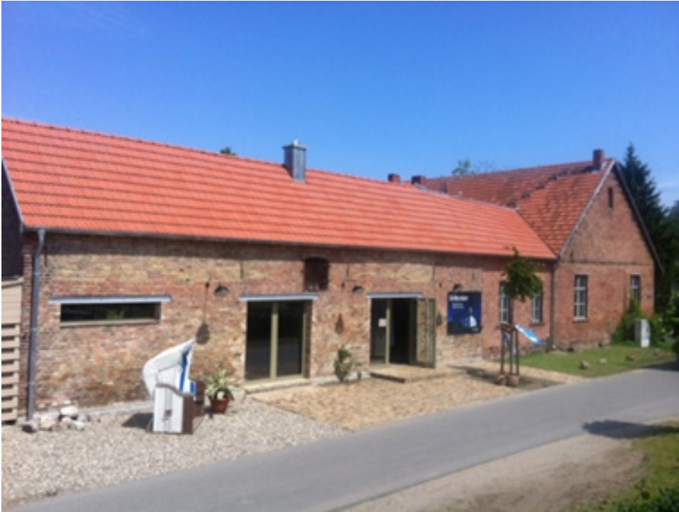
Bild 15: Außenansicht des Multiplen Hauses „Seesalon“, © Marco Dorka, traumHaff GmbH
