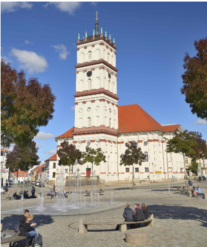
Bild 7: Sanierete Objekte der Stadt Neustrelitz: Stadtkirche Markt, © Stadt Neustrelitz/Roman Vitt-Fotografie
