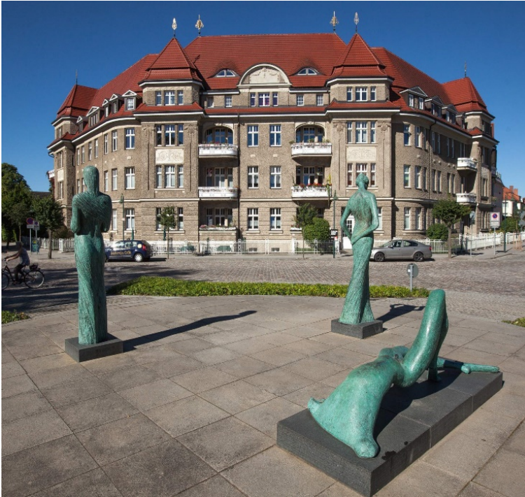
Bild 8: Sanierte Objekte der Stadt Neustrelitz: Gebäude an der Carlstraße/Elisabethstraße, © Stadt Neustrelitz/Bernd Lasdin
