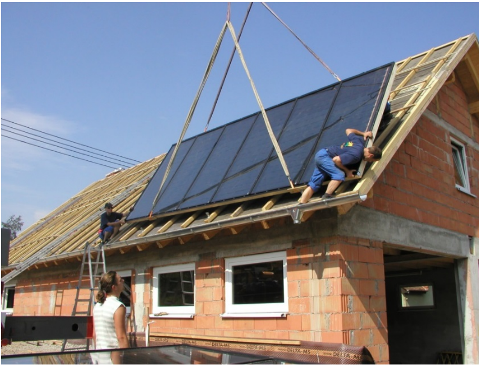
Bild 3: Neubau im Binsfelder Ortskern, © Franz-Josef Sauer/Das Dorf Service GmbH
