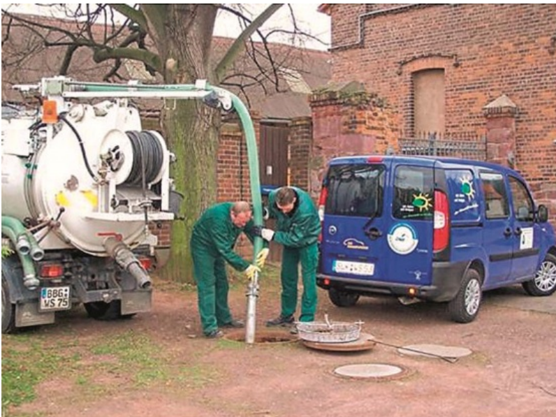
Bild 21: Abwasserentsorgung einer Gruppenkleinkläranlage, © Wasserzweckverband WZV "Saale-Fuhne-Ziethen"
