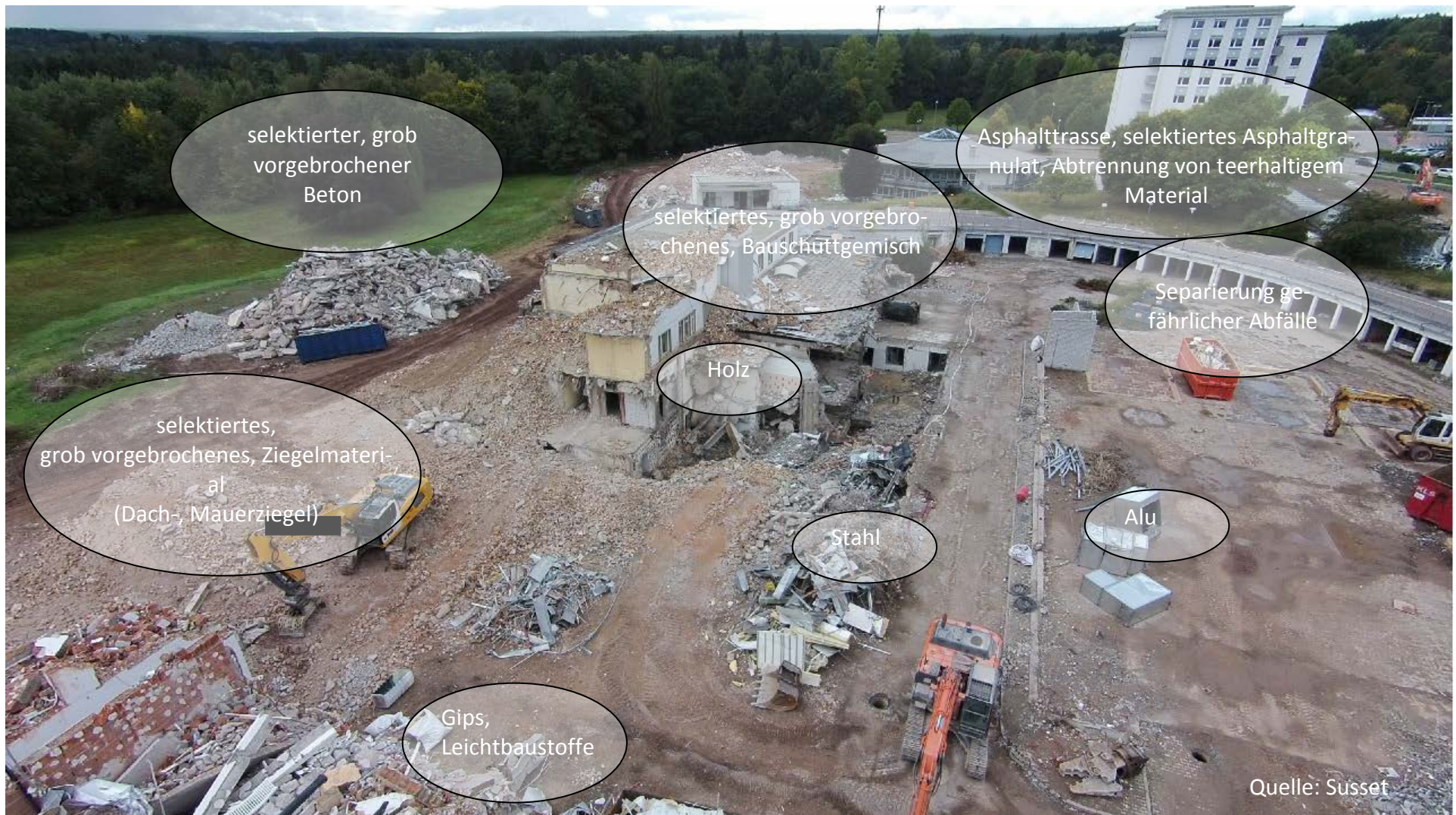
Abbildung 11: Selektierter Rückbau auf einer Großbaustelle (Quelle: eigenes Foto)
