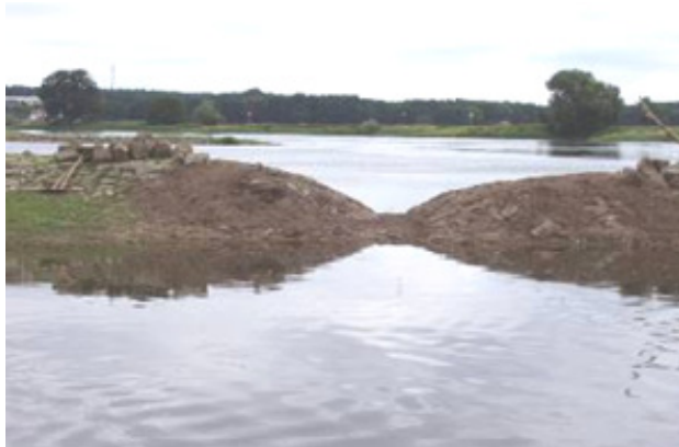
Abb. 1: Buhne 3 am linken Ufer während des Baus
