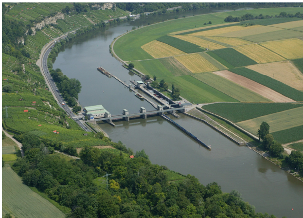
Abb 1: Die Staustufe Poppenweiler vor Bau- beginn (Foto: WSA Stuttgart)
