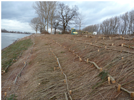
Abb. 3: Weidenspreitlagen nach Befestigung (14.12.2011)
