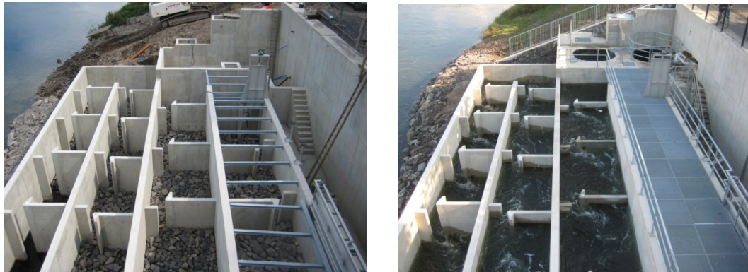
Abb. 2: Fischwechsellanlage Koblenz während und nach den Bauarbeiten“
