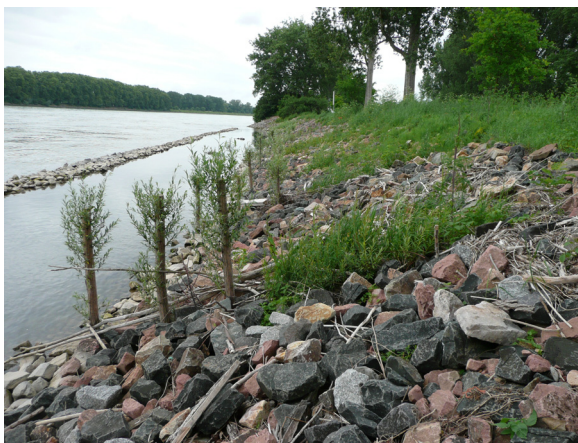
Abb. 2: Wellengeschützter Bereich und austreibende Weidensetzstangen (Juli 2012)
