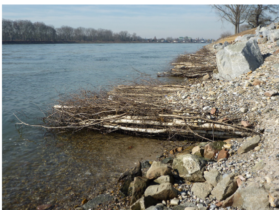
Abb. 5: Totholzfashinen (Niveau MW) und Strukturelemente auf der Böschung. Wasserstand ca. 130 cm unter MW
