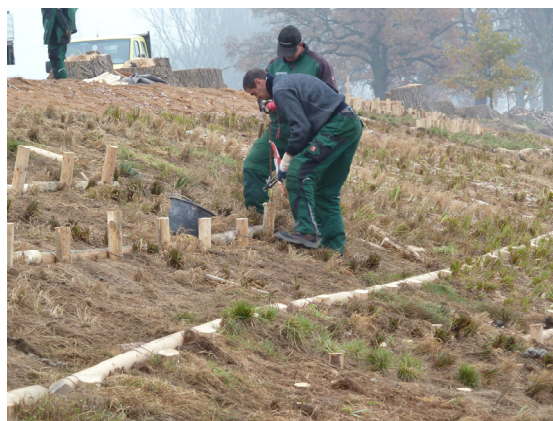
Abb. 6: Befestigung der Pflanzmatten mit Querriegeln und Pflöcken
