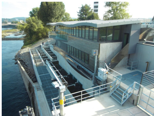
Abb. 3: Fischwechsellanlage Koblenz mit Informations- und Besucherzentrum
