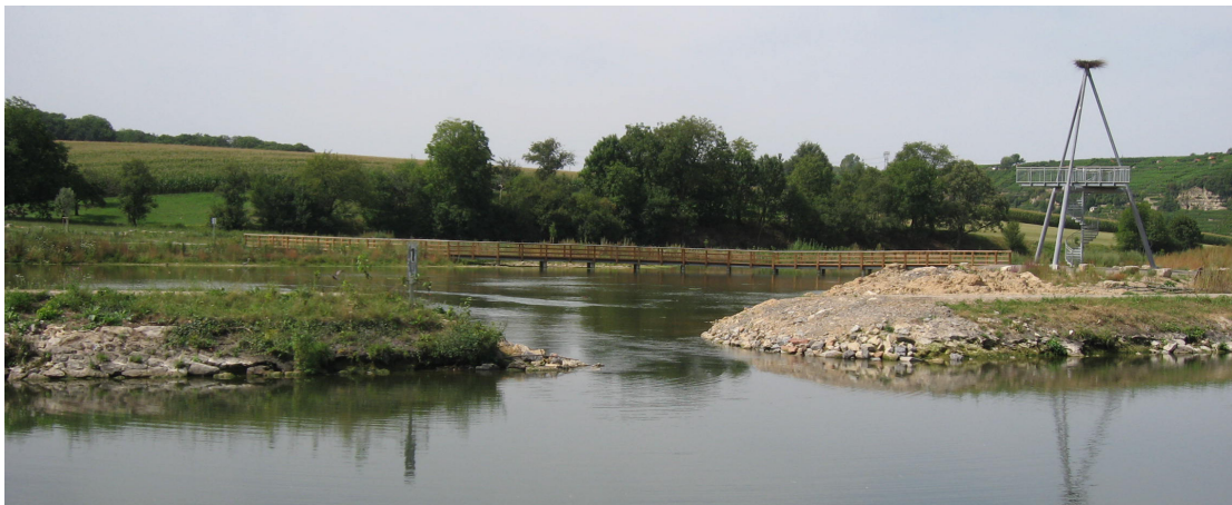
Abb. 7: Schnittstelle Flachwasserbereich und Bundeswasserstraße, Bauzustand Sommer 2012 (Foto: WSA Stuttgart)
