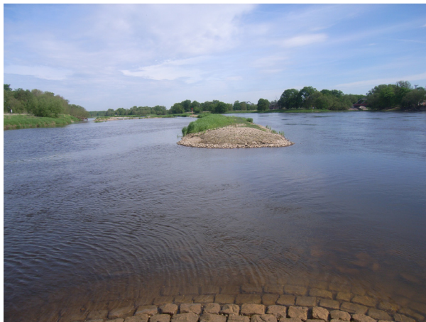
Abb. 10: Einlauföffnung nach Fertigstellung
