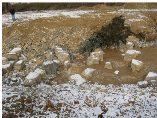
Abb 5: Die erste Neckarwasserwelle durchfließt das Umgehungsgerinne. (Foto: WSA Stuttgart)
