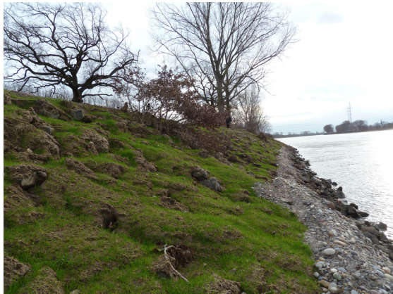
Abb. 9: Begrünung der Böschung durch Nassansaat und Oberbodenauftrag (14.12.2011)
