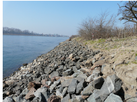
Abb. 10: Oberboden-mit Nassansaat nach HW-Ereignis abgetragen (März 2012)
