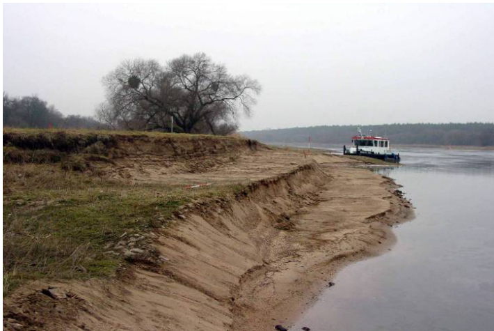
Abb. 6: Deckwerksbereich 2005 nach Entsigelung
