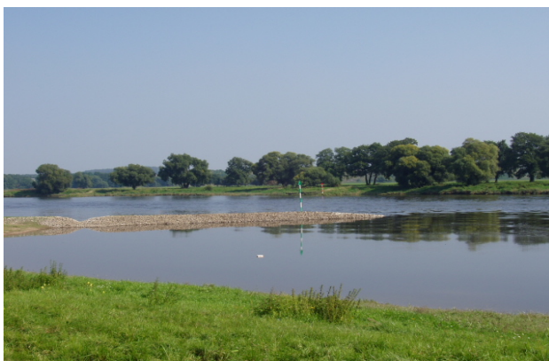
Abb. 2: Buhne 3 am linken Ufer nach Fer- tigstellung
