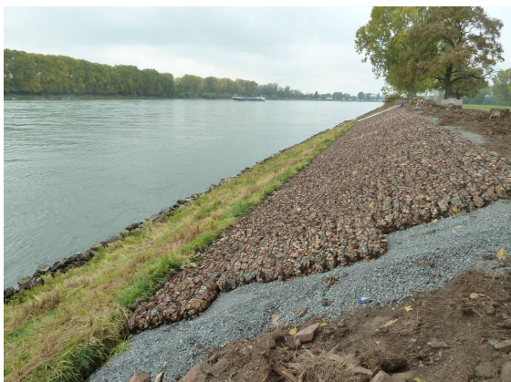
Abb. 7: Röhrichtgabionen (unterer Böschungsbereich) und daran anschließende Steinmatratzen (20.10.2011 während der Bauzeit)
