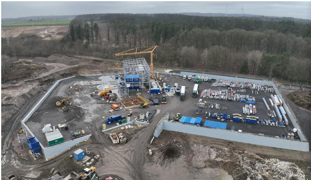
Abbildung 7 Drohnenbild der Baustelle
