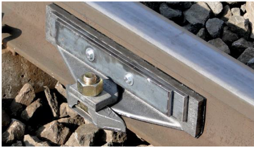
Abbildung 20: Schienenstegdämpfer an der Schiene
