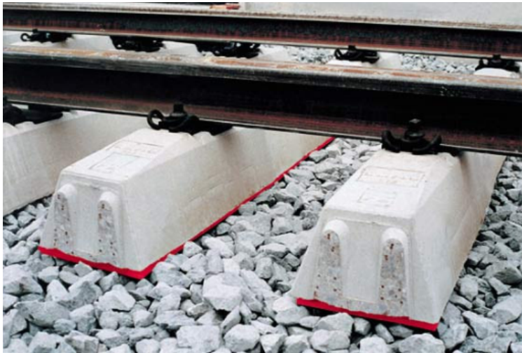
Abbildung 19: Schwellenbesohlung (rot) an Betonschwellen auf Schotter
