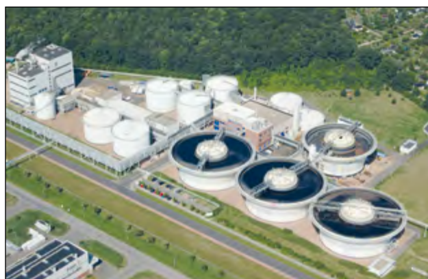
Photograph: Gemeinschaftskläwerk Bitterfeld-Wolfen GmbH
