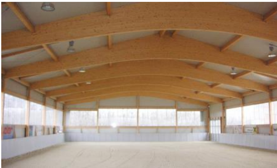
Abbildung 17: Brettschichtholz binder einer Hallenkonstruktion
