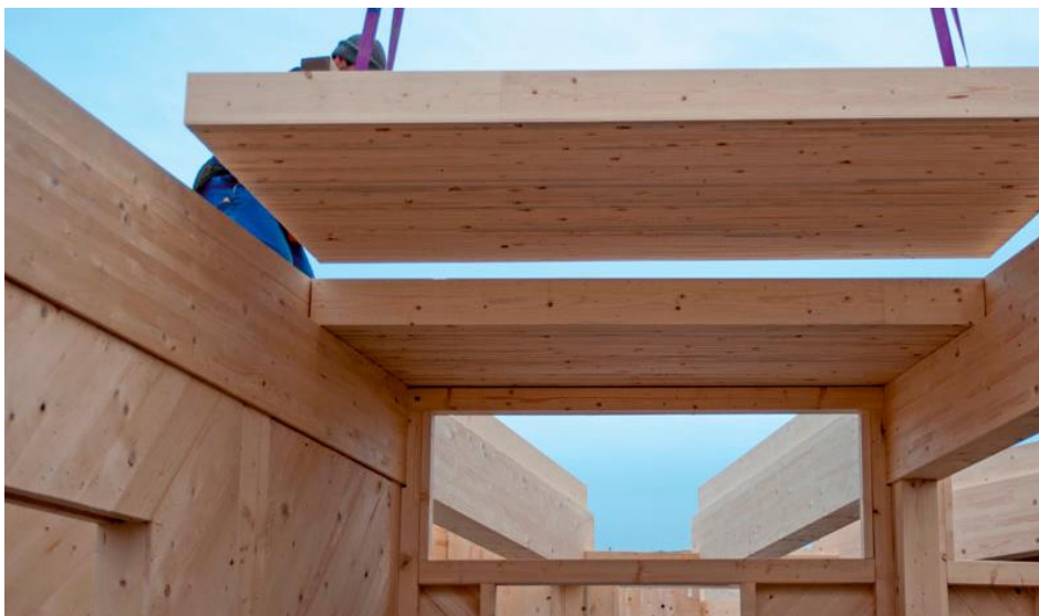
Abbildung 15: Massivholzbau mit Brettstapeldecke, Unterzügen und Brettsperrholzwänden
