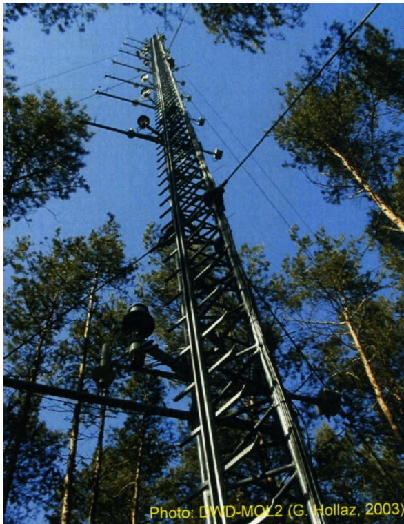
Abbildung 3 Messturm im Forst Kehrigk
