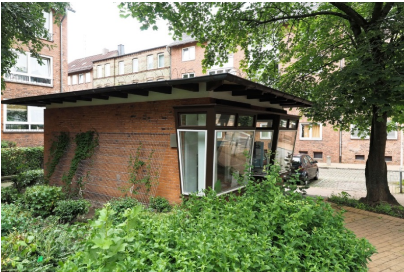
Abbildung 17: Energieberatung im „Auguste“-Kiosk
