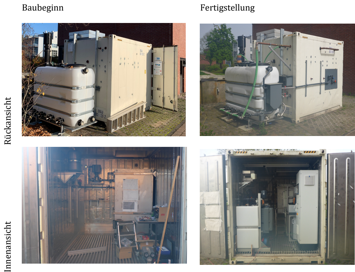
Abbildung 13: Baufortschritt des großen Pilot-MBR.
