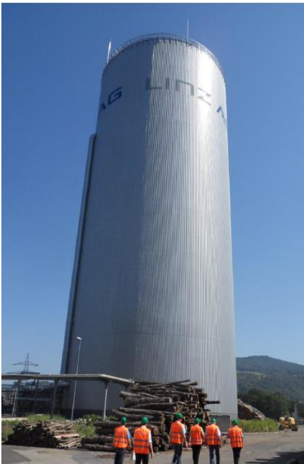
Abbildung 105: Oberirdisch realisierter Stahltank der Fernwärme Linz AG
