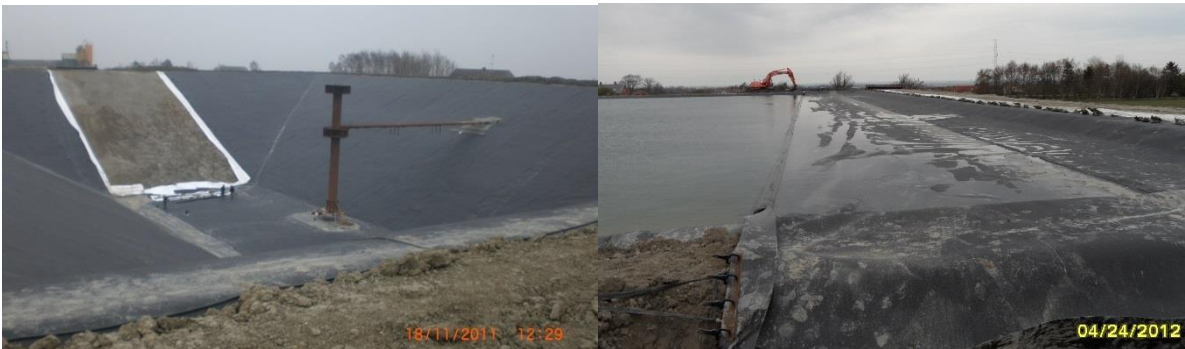
Abbildung 113: Fotos des Erdbecken-Wärmespeichers während der Bauzeit; links: Auskleidung der Baugrube und Be-/ Entladeturm; rechts: Aufbringen der Abdeckfolie auf der Wasseroberfläche
