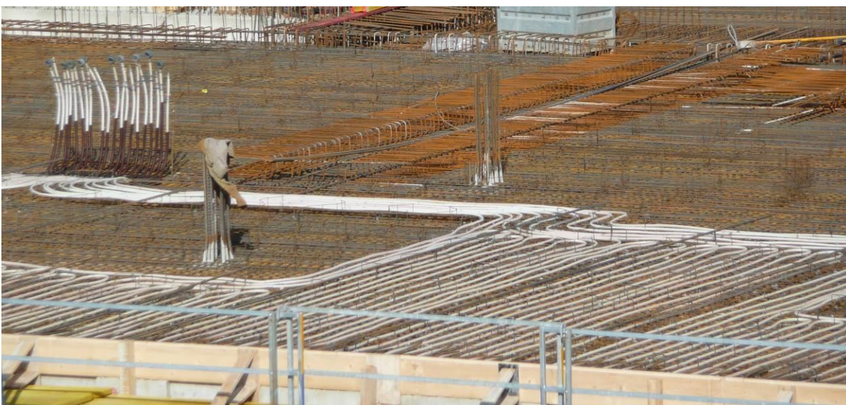
Abbildung 97: Einbau einer Baukernaktivierung in eine zu betonierende Decke
